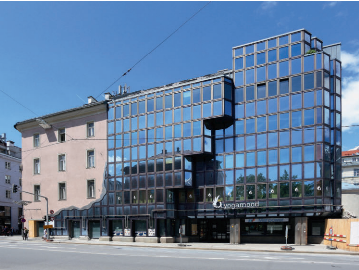
Abb. 18: Fassade des Bankgebäudes Anglo-Elementar, 6020 Innsbruck
